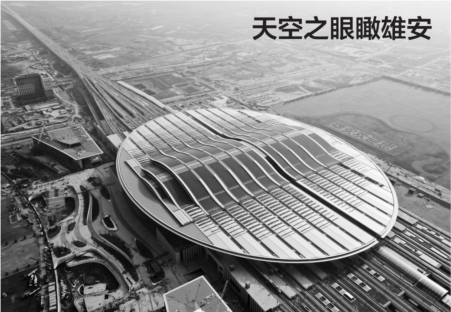
这是4月1日拍摄的雄安站(无人机照片)。雄安新区已进入大规模开发建设阶段，超过10万名建设者正在雄安新区建设施工，120多个重大项目同步推进。这座“未来之城”是梦想起航的地方，一个日新月异的新雄安正向我们走来。 新华社记者 邢广利摄
