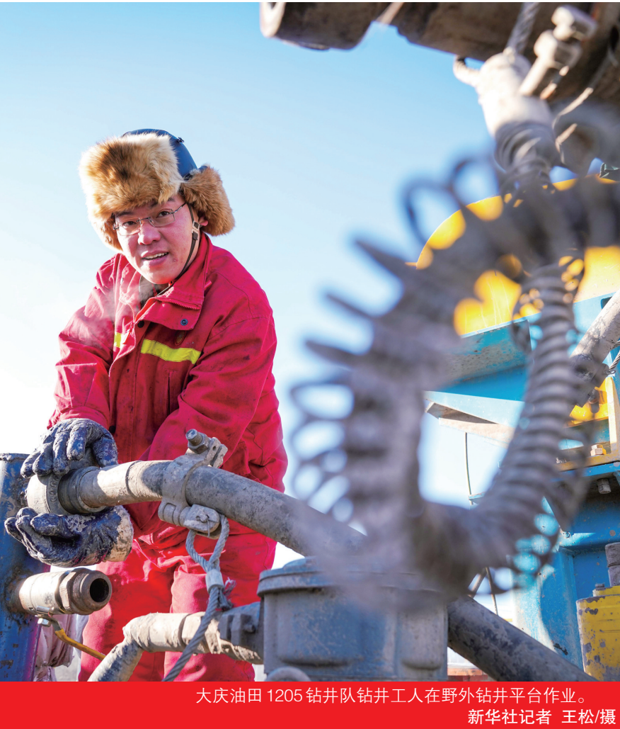
大庆油田1205钻井队钻井工人在野外钻井平台作业。 新华社记者 王松/摄
