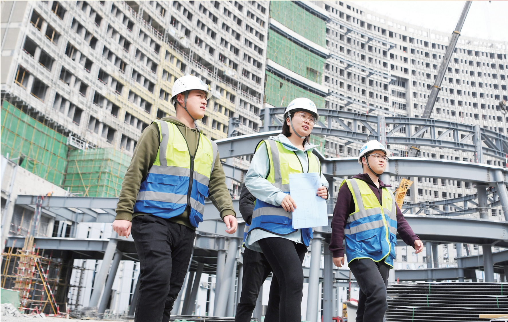
杜萱(中)带领技术人员从甘肃省妇女儿童医疗综合体项目三标段工地上走过(3月4日摄)。1988年出生的杜萱是中建三局西北公司唯一的女总工程师,目前负责该公司承建的甘肃省重点建设项目——甘肃省妇女儿童医疗综合体项目三标段。从普通技术员到项目总工程师,她带领团队攻坚克难,获得了多项专利和全国建设工程项目管理成果一等奖、中建三局“巾帼标兵”称号。“建筑也是一门艺术,做好它,就要有一颗时刻跳动的匠‘心’。” 新华社记者 陈斌/摄
