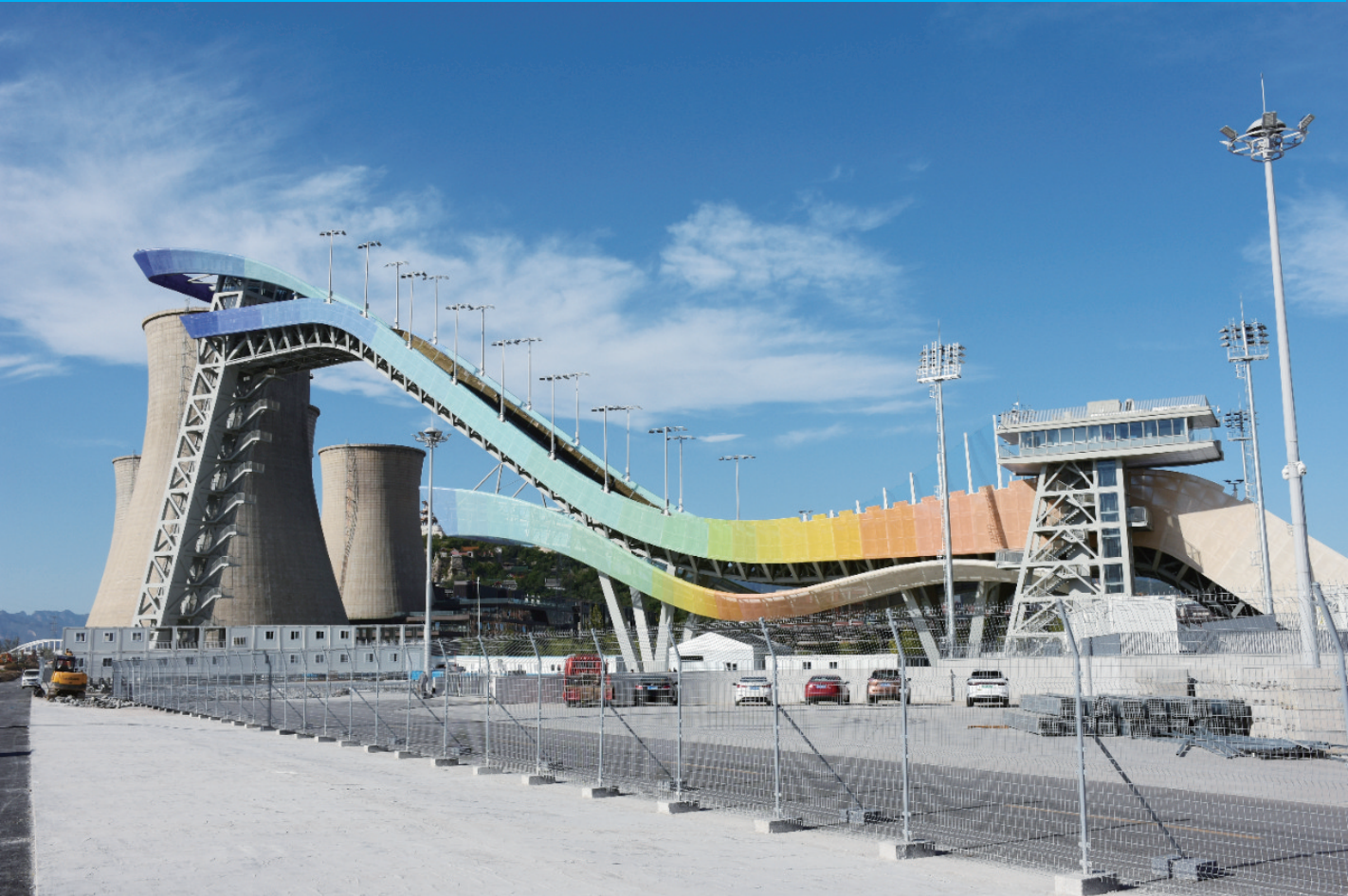
建设中的首钢滑雪大跳台。
