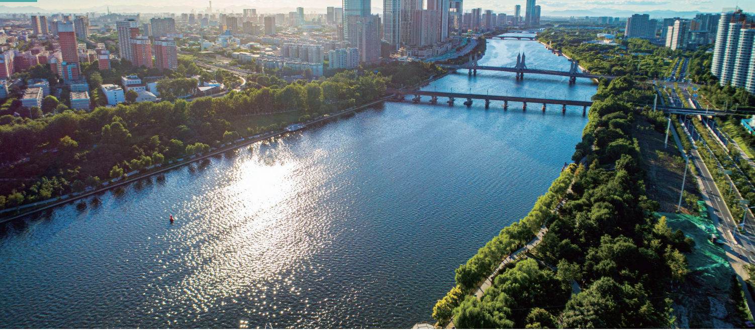
这是在北京市通州区拍摄的横跨大运河的玉带河桥(2022年8月15日摄,无人机照片)。 新华社发(刘宇/摄)
