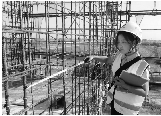
余丹在施工现场进行钢筋工程验收。
