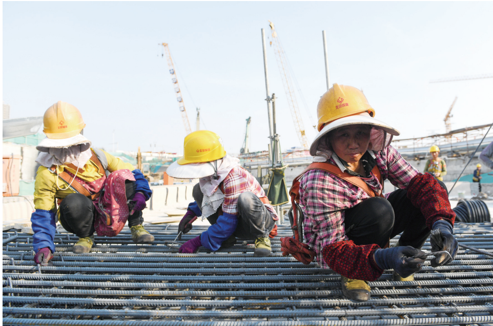
近日，在北京城市副中心站综合交通枢纽项目02标段北京城建设施工现场，工人在捆扎钢筋。为了应对高温天气，工地已调整作息时，施工时间避开了中午高温时段。
