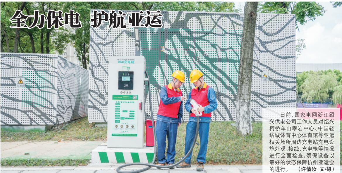
日前，国家电网浙江绍兴供电公司工作人员对绍兴柯桥羊山攀岩中心、中国轻纺城体育中心体育馆等亚运相关场所周边充电站充电设施外观、接线、充电枪等情况进行全面检查，确保设备以最好的状态保障杭州亚运会的进行。（许倩汝 文/摄）
