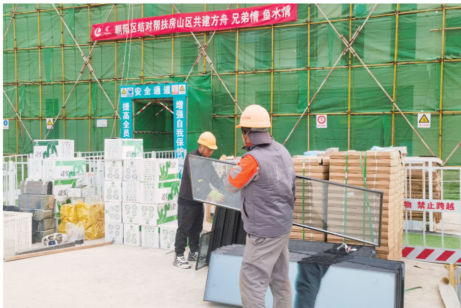
十渡应急保障中心施工现场。 崔安琪/摄
