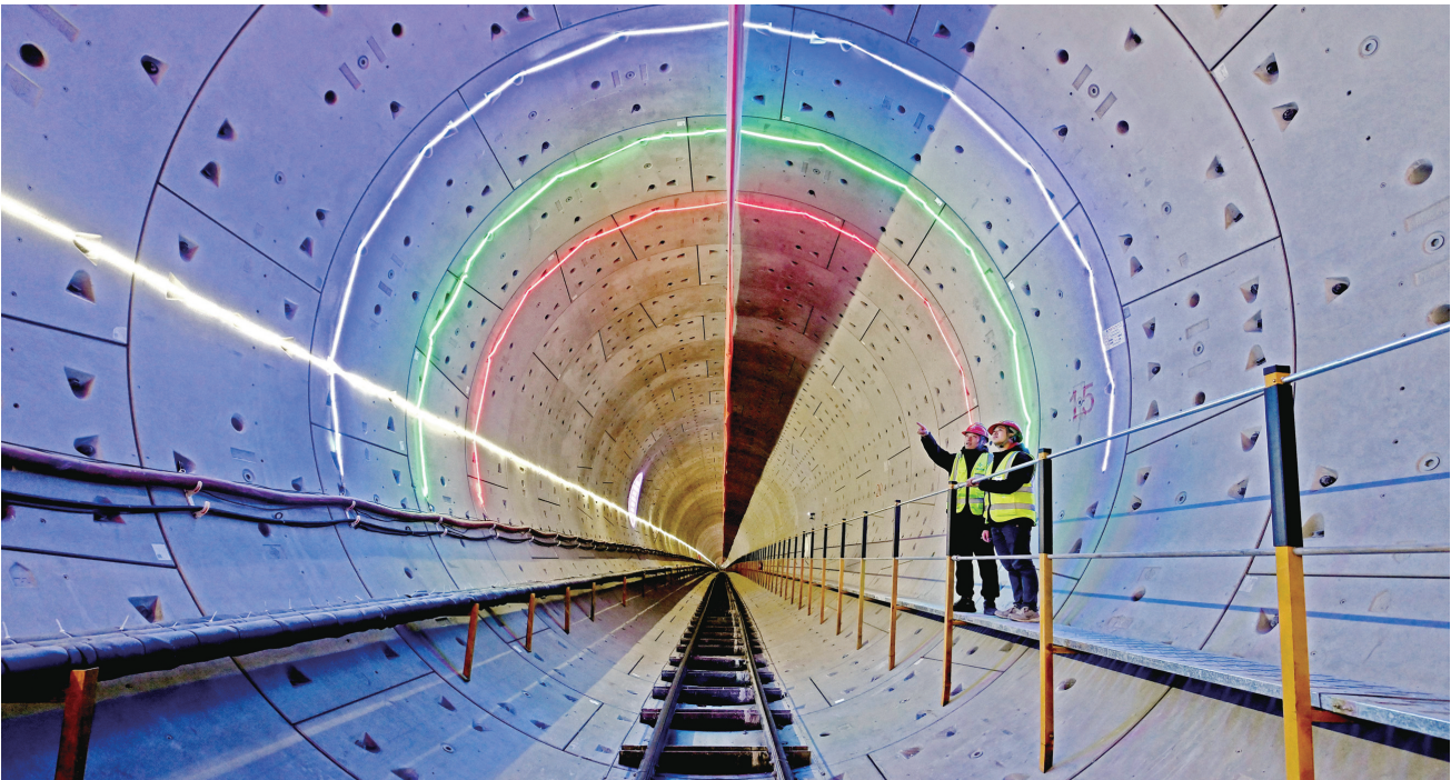
二〇二四年二月三日，工作人员在北京轨道交通二号线河北段盾构隧道内进行巡查。新华社记者 王晓摄
