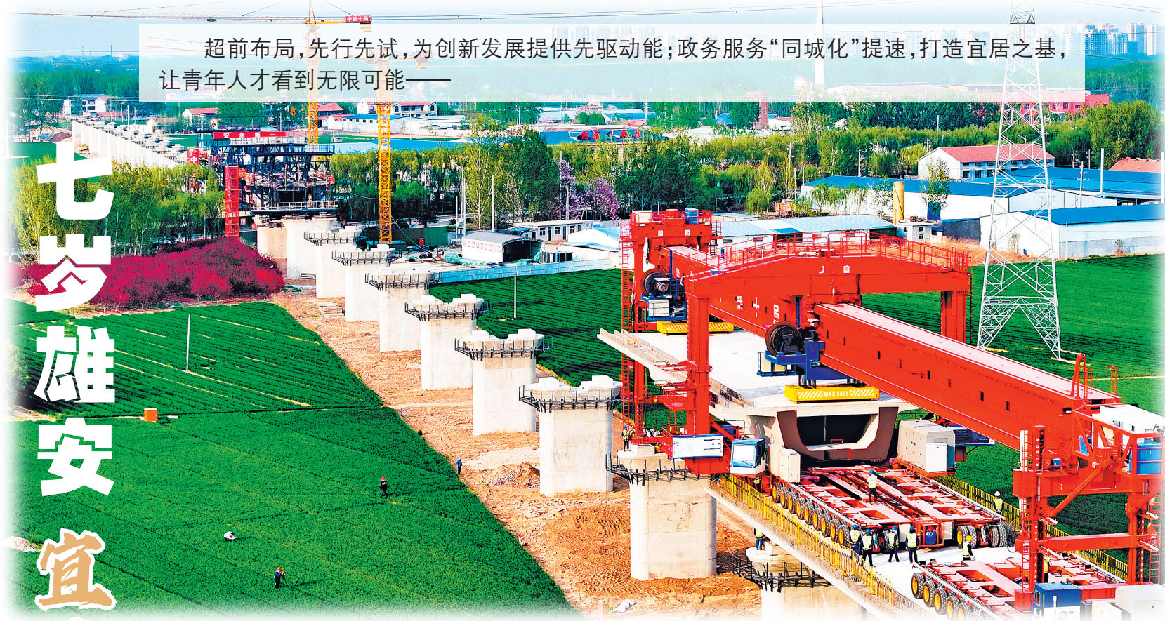
在雄商高铁山东菏泽段,中铁十局的工作人员在进行架梁作业(无人机照片,4月12日摄)。
