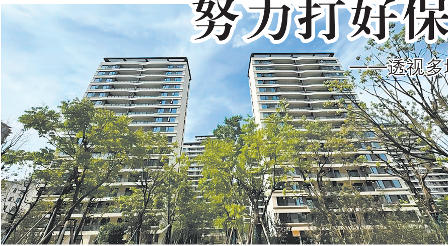
上海祥生·城市之光小区,目前整体工程进度已完成90%,预计7月份所有工程作业全部结束。来源:新华社
