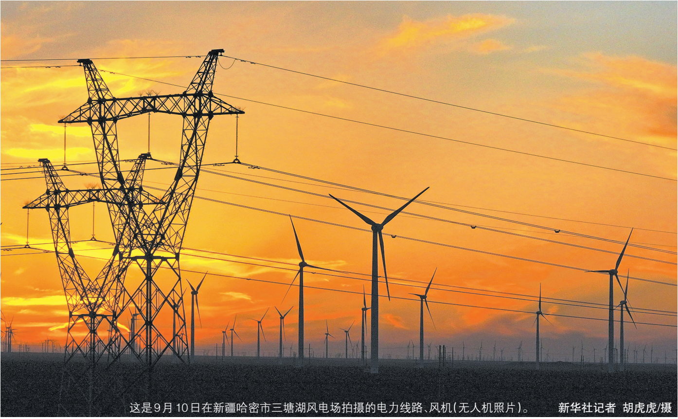
这是9月10日在新疆哈密市三塘湖风电场拍摄的电力线路、风机(无人机照片)。 新华社记者 胡虎虎/摄
